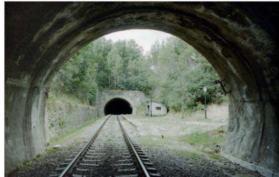
La estación de La Acebeda se construyó entre dos túneles (2001).
